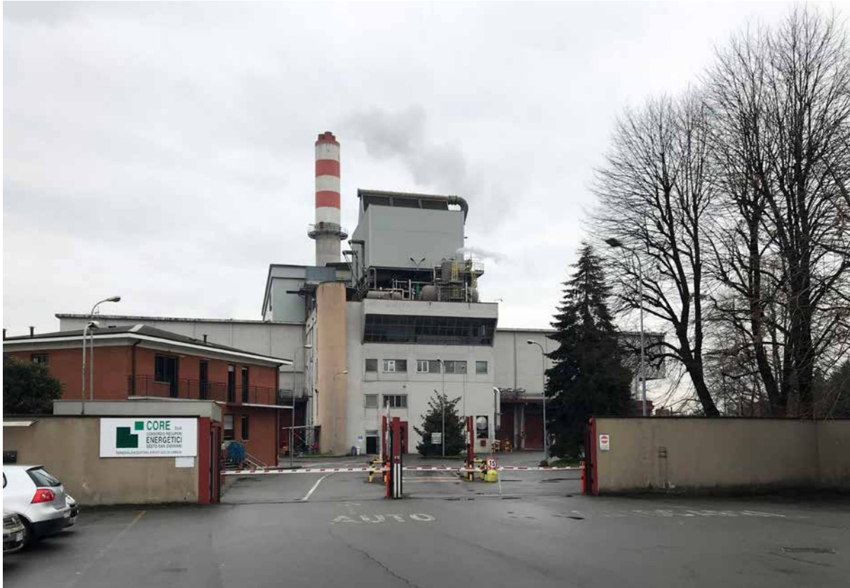
L'ingresso e il piazzale di scarico dove verrà realizzata l'avanfossa
