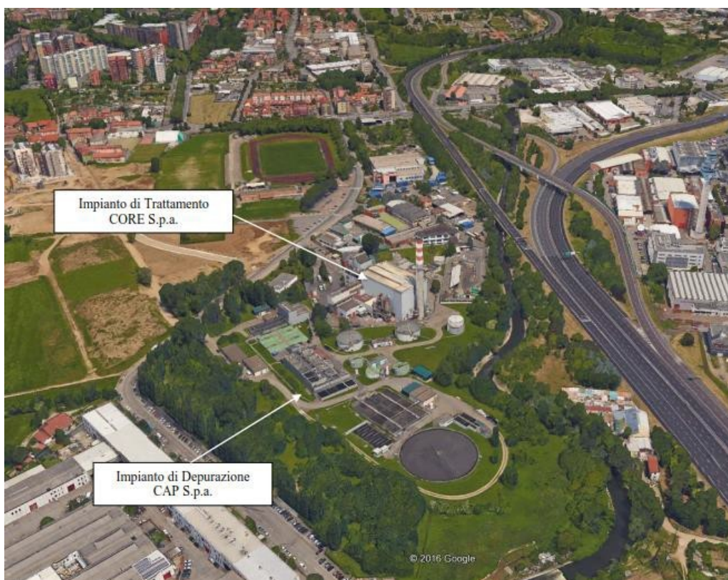
Veduta generale degli impianti e dell'intorno
