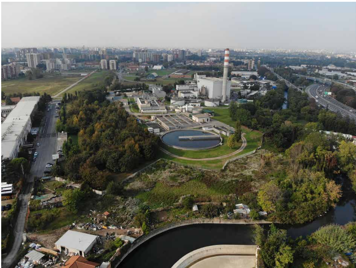
Il verde a perimetro degli impianti CAP-CORE
