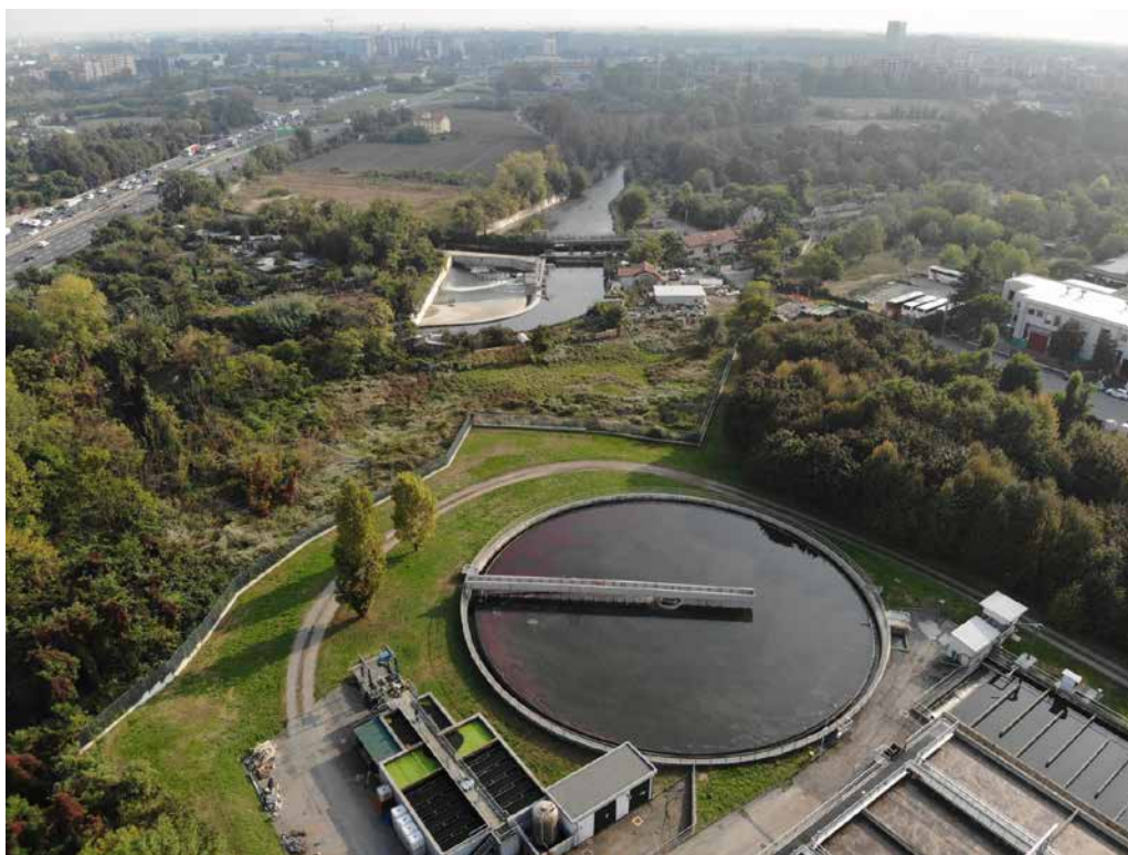
Le aree a Sud dell'impianto CAP, lo scolmatore del Lambro ed il ponte del Naviglio Martesana
