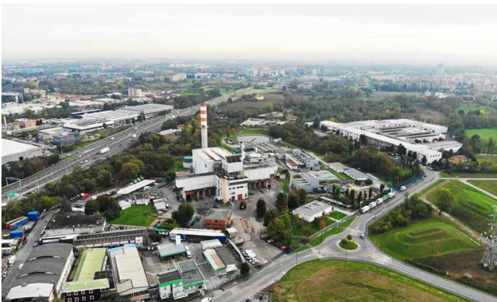
Situazione attuale, l'area CAP CORE vista da nord
